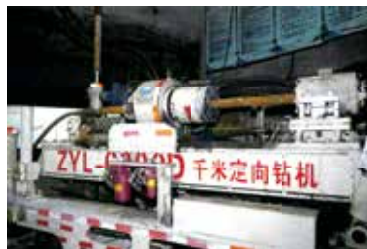
千米定向钻机井下作业现场
