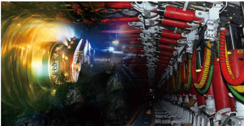
高效运行的智能化综采设备
