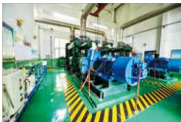
地面瓦斯泵房
