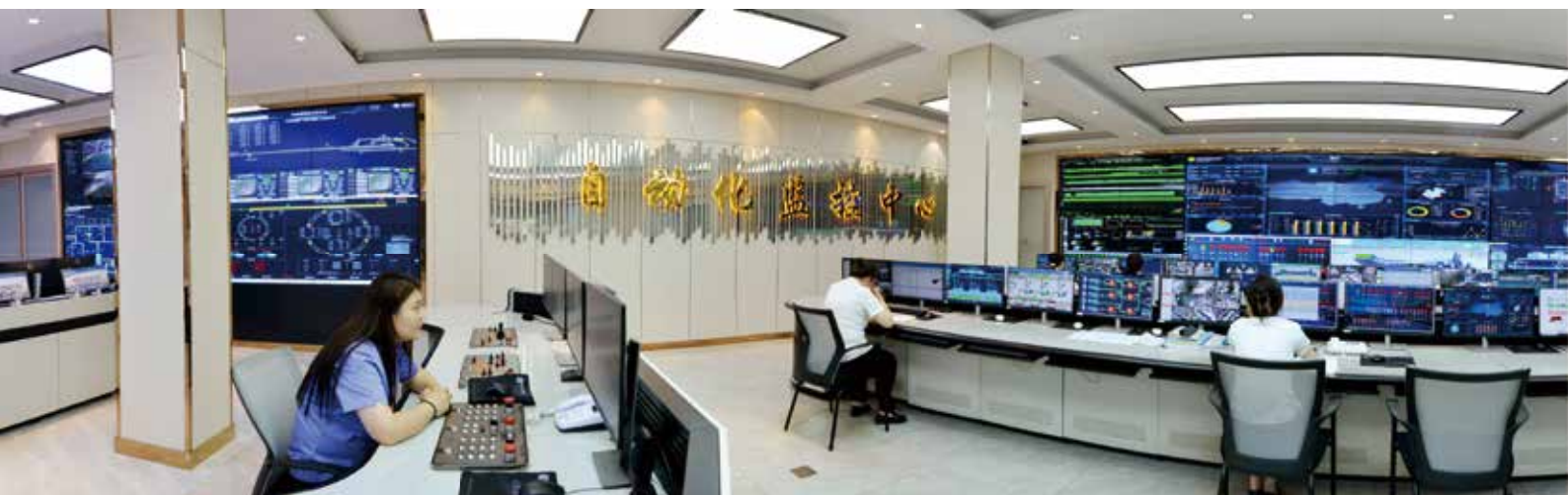
海石湾煤矿自动化监控中心
